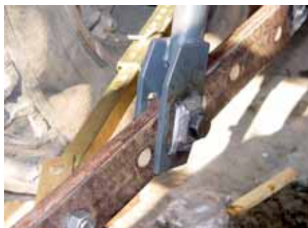
Fot. 1. Nowe belki dolne zostały wykonane z belek połowych, a widełki wieszaków wzmocniono nakładkami.
