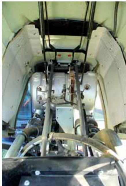
Filtr DPF umieszczony jest za silnikiem, tuż przy kabynie.
